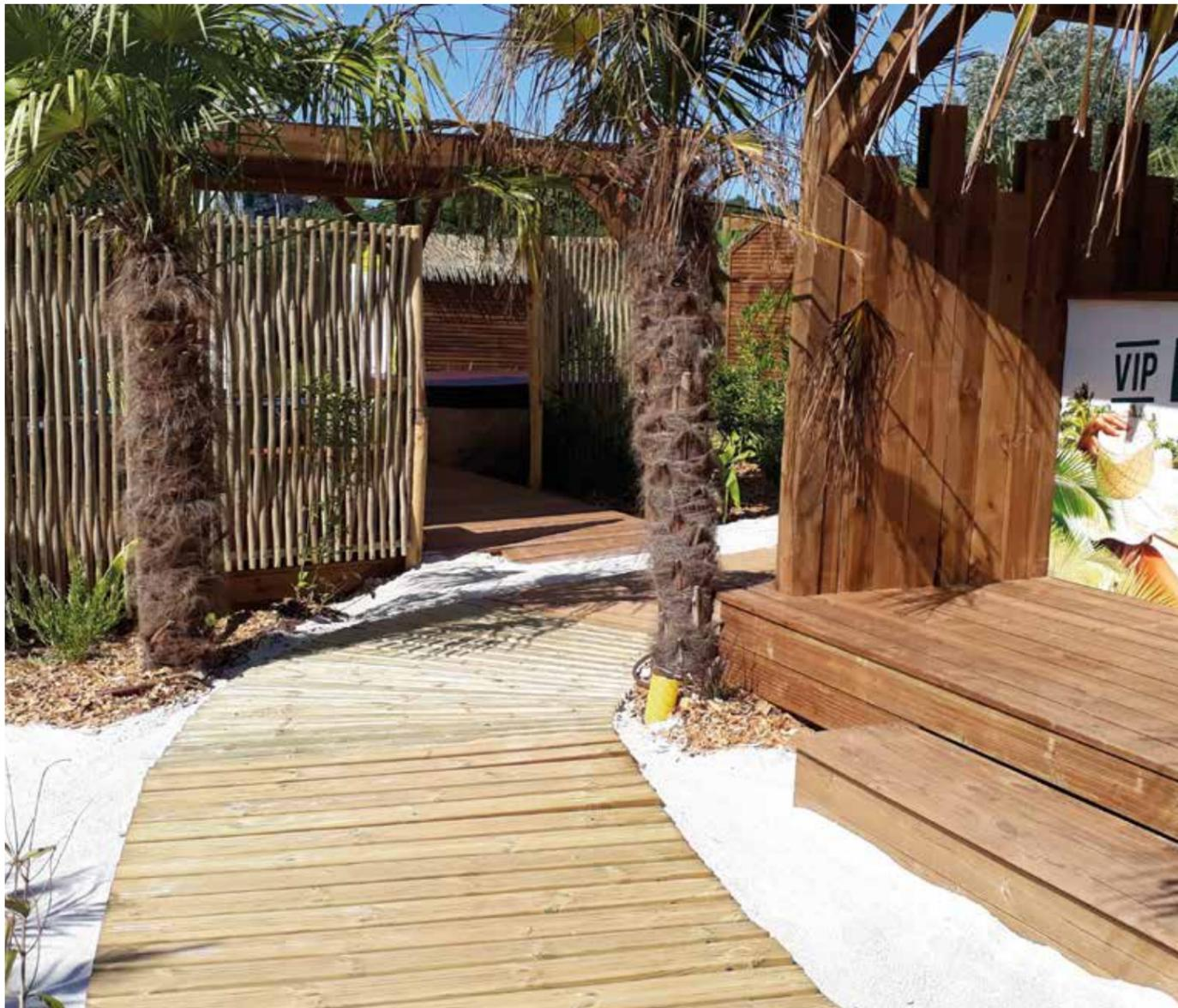
Aménagement des zones de circulation : platelage amovible en PIN CLASSE 4 - Module standard et sur mesure - Palissades Pretoria en EUCALYPTUS, palissades en PIN CLASSE 4.
